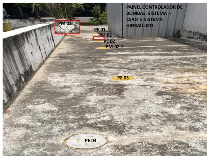
Figura 10. Foto da localização dos poços de bombeamento.
